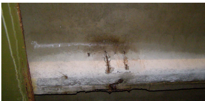
2.11 pav. Plokščių išilginių briaunų skersinės armatūros jungiamojo strypo pažeidimai
