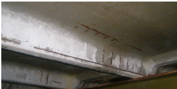
2.11 pav. Plokščių išilginių briaunų skersinės armatūros jungiamojo strypo pažeidimai
