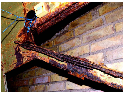
2.24 pav. Santvaros ašyje (11) tinklelio elementų T-7, T-8 ir T-9 sandūros mazgo būklė
