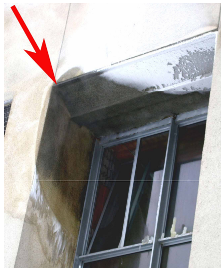
1.8 pav. Drėgmės ir šalčio pažeistų pastato šiaurės vakarų fasado angokraščių vaizdas
