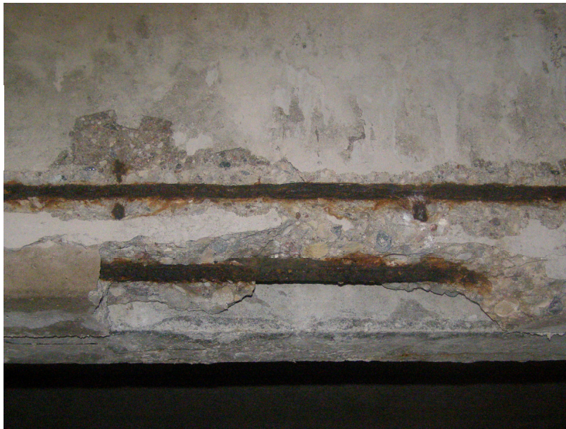
2.6 pav. Denginio plokščių išilginių briaunų pagrindins išlanksto įtemptosios armatūros pažeidimai
