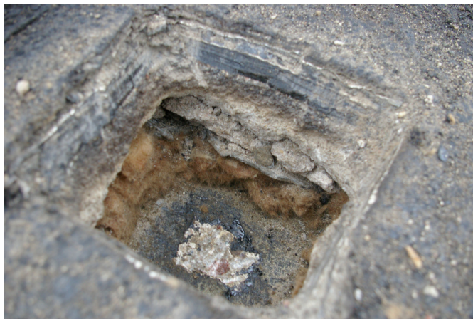
2.2 pav. Stogo dangos vaizdas tyrimų metu
