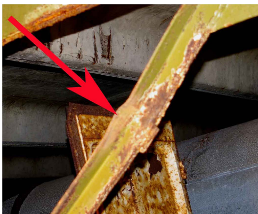
2.21 pav. Deformuotas santvaros ašyje (6) tinklelio elementas T-9
