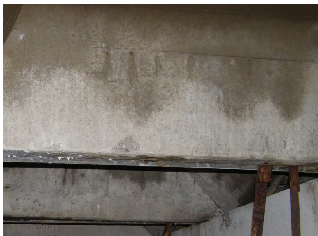
2.3 pav. Stogo plokštės, esančios B ašyje, sudrėkusios dėl blogos stogo dangos
