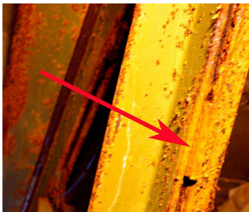
2.23 pav. Vienpusis santvaros ašyje 11 tinklelio elemento T-11 intarpo privirinimas
