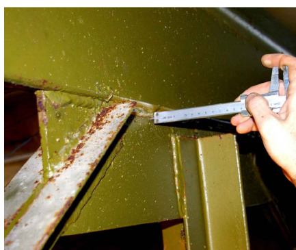
2.20 pav. Mažas santvaros ašyje (6) mazginio lakšto suvirinimo siūlės statinis
