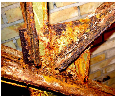
2.24 pav. Santvaros ašyje (11) tinklelio elementų T-7, T-8 ir T-9 sandūros mazgo būklė
