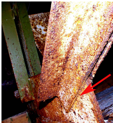
2.16 pav. Neprivirintas tinklelio elementas
