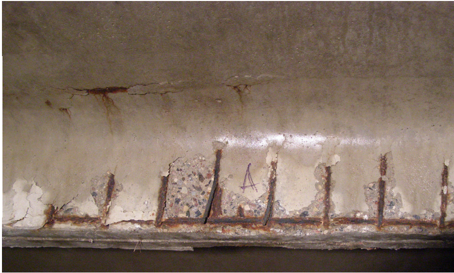
2.9 pav. Denginio plokščių išilginių briaunų skersinė armatūra atšokusi nuo jungiamojo strypo
