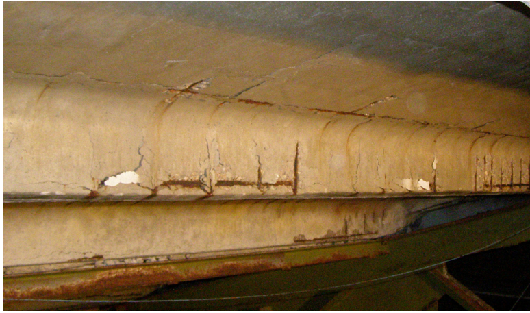
2.5 pav. Denginio gelžbetoninių plokščių bendras vaizdas
