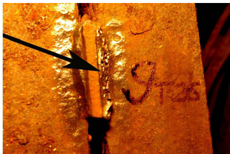
2.22 pav. Santvaros tinklelio elementų suvirinimo siūlės kokybė
